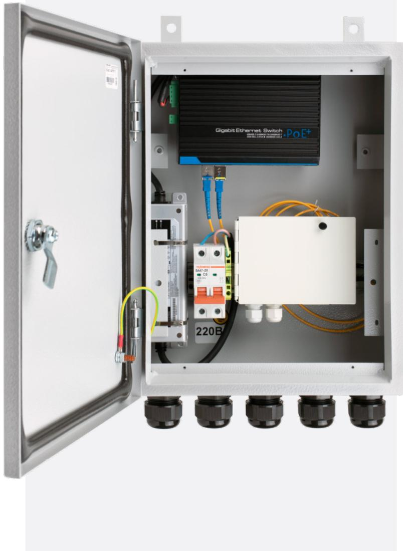
Решение позволяет произвести подключение камер и самого узла к оптоволоконной сети без приобретения дополнительных расходников.
